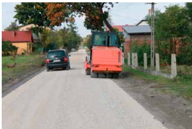
Wyremontowana droga w Jaworze - II etap
