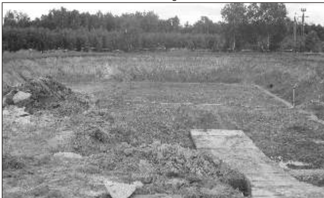
Prace przy oczyszczalni ruszyły pełną parą
