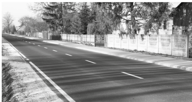
Wyremontowana przez Powiat Belchatowski droga w Pożdżenicach.
