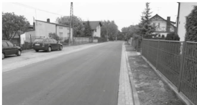
Wyremontowana droga w Maurycowie.
