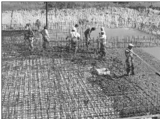
To już historyczne zdjęcie. Ściany zbiornika bioreaktora są już bowiem wykonane w całości.
